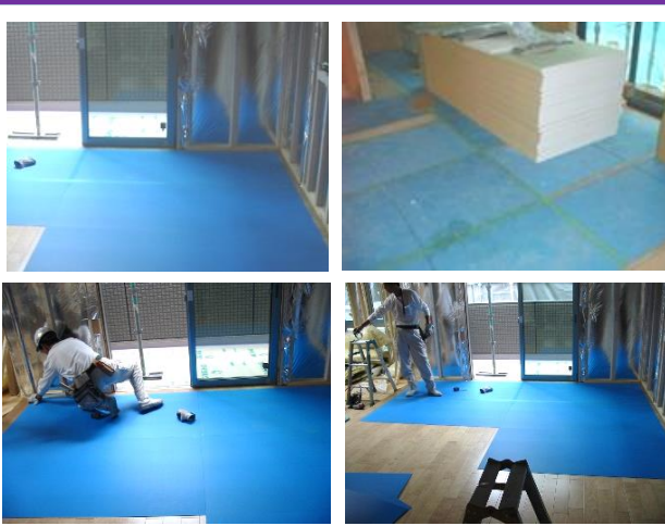
建築現場の養生
