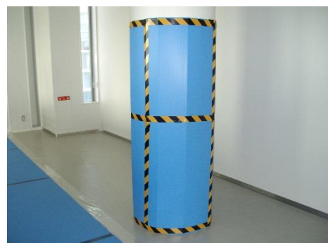
丸い柱に沿わせて養生
