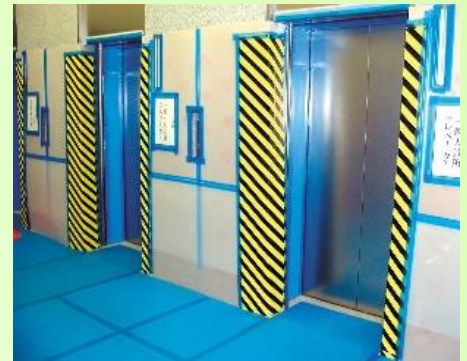
エレベーターやエントランスも簡単に養生
